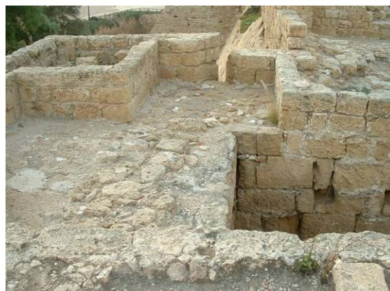
Tour d'angle rectangulaire fermée à la gorge de dimensions extérieures 19,79 x 4,84 (E) x 4,3 (W) m. Parements extérieurs en maçonnerie de type A ; niveau bas plein enchapé dans le glacis ; niveau haut reconstruit en anastylose sur quelques assises par Avraham Negev, comportant quatre archères frontales vers le sud et une archère par face latérale.
