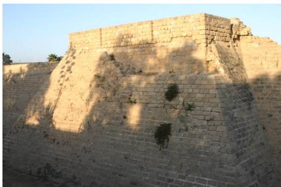
Tour rectangulaire fermée à la gorge de dimensions extérieures 11,35 x 4,13. Parements extérieurs en maçonnerie de type A ; niveau bas aveugle enchapé dans le glacis ; niveau haut reconstruit en anastylose sur quelques assises par Avraham Negev, comportant deux archères frontales et une archère par face latérale.
