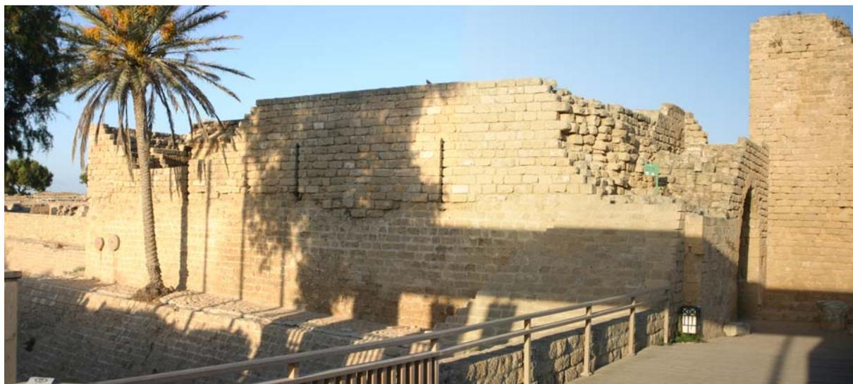
Tour-porte rectangulaire de dimensions extérieures 23,37 x 8,8 (N) 10,44 (S). Parements extérieurs en maçonnerie de type A ; niveau bas aveugle enchapé dans le glacis en dehors de la porte d'accès ; niveau haut totalement reconstruit en anastylose par Avraham Negev. Pour sa partie franque, la porte a déjà été publiée (Mesqui-Faucherre 2006).
