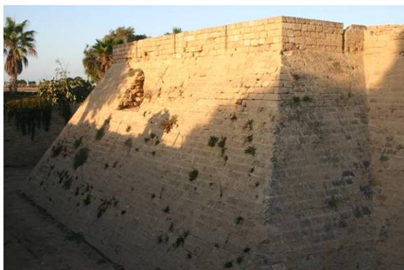
Tour d'angle rectangulaire fermée à la gorge de dimensions extérieures 14,92 x 13,65 x 4,2 x 5,9 m. Parements extérieurs en maçonnerie de type A ; niveau bas plein enchapé dans le glacis ; niveau haut reconstruit en anastylose sur quelques assises par Avraham Negev, comportant trois archères frontales vers l'est, deux archères frontales vers le sud, et une archère par face latérale.
