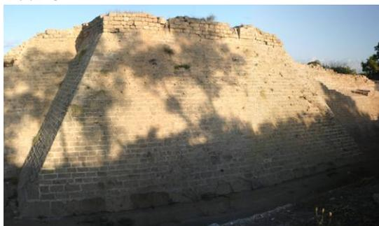
Tour rectangulaire ouverte à la gorge, de dimensions extérieures 12,20 x 5,38. Parements intérieurs et extérieurs en maçonnerie de type A ; niveau bas aveugle enchapé dans le glacis extérieur ; niveau haut conservé sur plusieurs assises permettant de reconnaître les niches de deux archères frontales et d'une archère par face.
