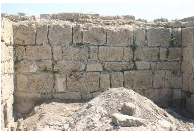
Tour rectangulaire ouverte à la gorge, dimensions extérieures 12,1 x 5,17. Parements extérieurs en maçonnerie de type A ; niveau bas aveugle enchapé dans le glacis extérieur ; niveau haut conservé sur une à deux assises permettant de reconnaître les niches de deux archères frontales, et d'une archère sur les deux faces latérales.
