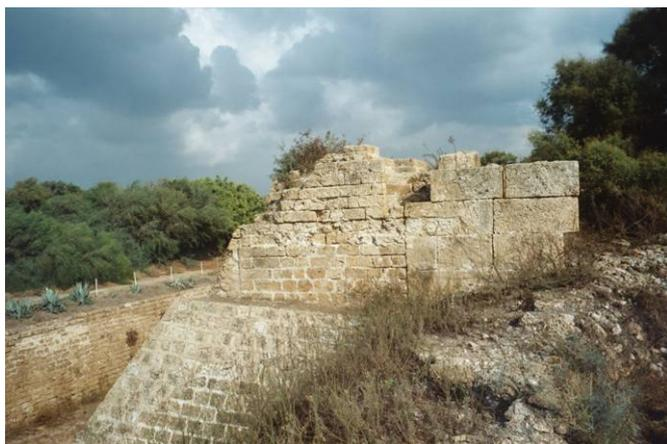
Tour rectangulaire de 24,15x16,15 m. Le niveau conservé (seul connu avant la mission) est constitué d'une gaine à archères construite en appareil de type A (1251-52) venant enchaper une construction rectangulaire en maçonnerie de grands carreaux (hauteur 58-62 cm), la jointure étant parfaitement visible en face ouest (ci-contre). Ces particularités expliquent pourquoi cette tour avait été retenue pour une fouille.
