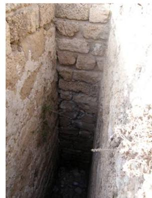
Le mur d'enceinte de l'époque Saint-Louis, en appareil de type A, se trouve à 3,11 m du parement extérieur. Au nord est conservé le départ d'un escalier montant sur le chemin de ronde de la courtine ; vers l'ouest, la courtine est doublée par un mur de 1,3 m d'épaisseur accueillant un escalier d'accès au premier étage depuis la ville, et une coursière longeant la tour.
