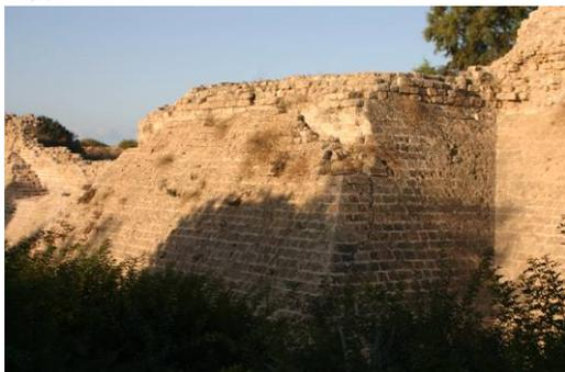
Tour rectangulaire ouverte à la gorge, dimensions extérieures 12,4 x 4,9 m. Parements intérieurs et extérieurs en maçonnerie de type A ; niveau bas aveugle enchapé dans le glacis extérieur ; niveau haut conservé sur une à deux assises permettant de reconnaître les niches de deux archères frontales et d'une archère par face. Plusieurs marches d'un escalier montant sur le chemin de ronde de la courtine sont conservées à l'angle nord-ouest.
