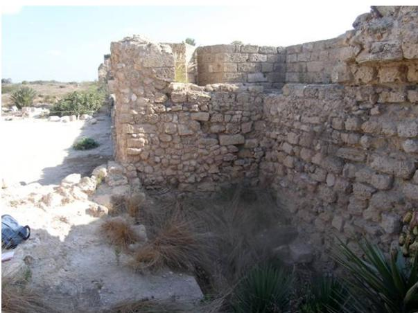
Tour rectangulaire fermée à la gorge de dimensions extérieures 11,34 x 4,04. Parements extérieurs en maçonnerie de type A ; niveau bas aveugle enchapé dans le glacis ; niveau haut reconstruit sur quelques assises par Avraham Negev en conservant des massifs de maçonnerie originels.
