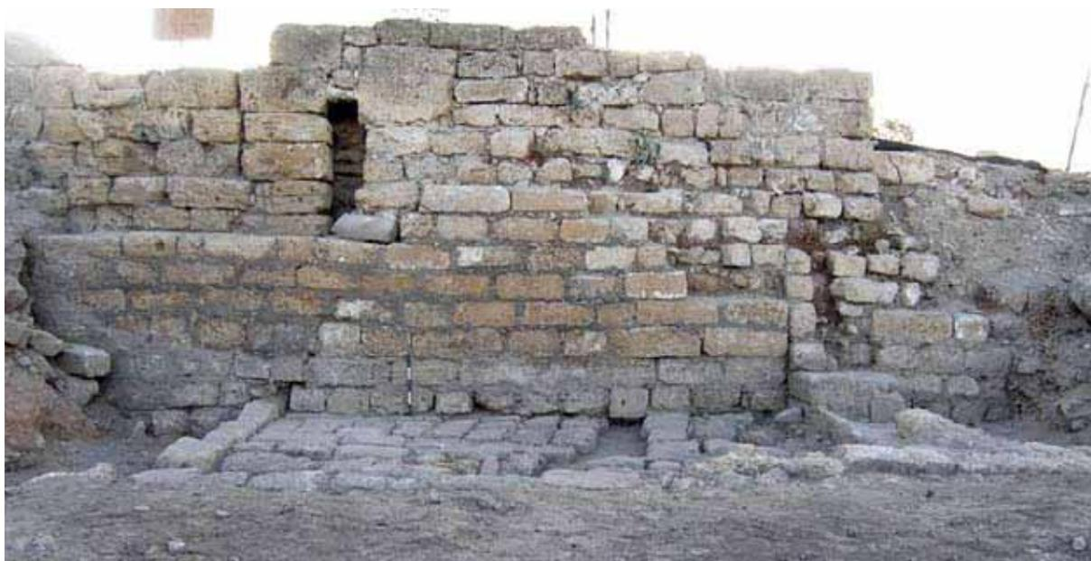
**Figure 96 : Vue de la face Ouest de la tour, en 2009. Au premier plan, le dallage du bâtiment accolé aux ouvrages primitifs. Au-dessus, les six assises de l'épaississement. Au-dessus encore, sur la gauche, le parement de la pile M4, et sur la droite, séparé par un creux vertical, la maçonnerie bosniaque moderne.**
