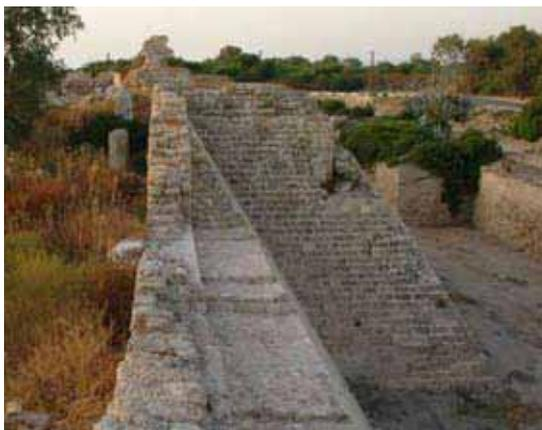
**Figure 63 : Vue de la tour T4 prise du Sud en 2008. À gauche, les deux colonnes dressées. Au premier plan, l'épaississement du mur primitif et le glacis Saint Louis vus en coupe.**
