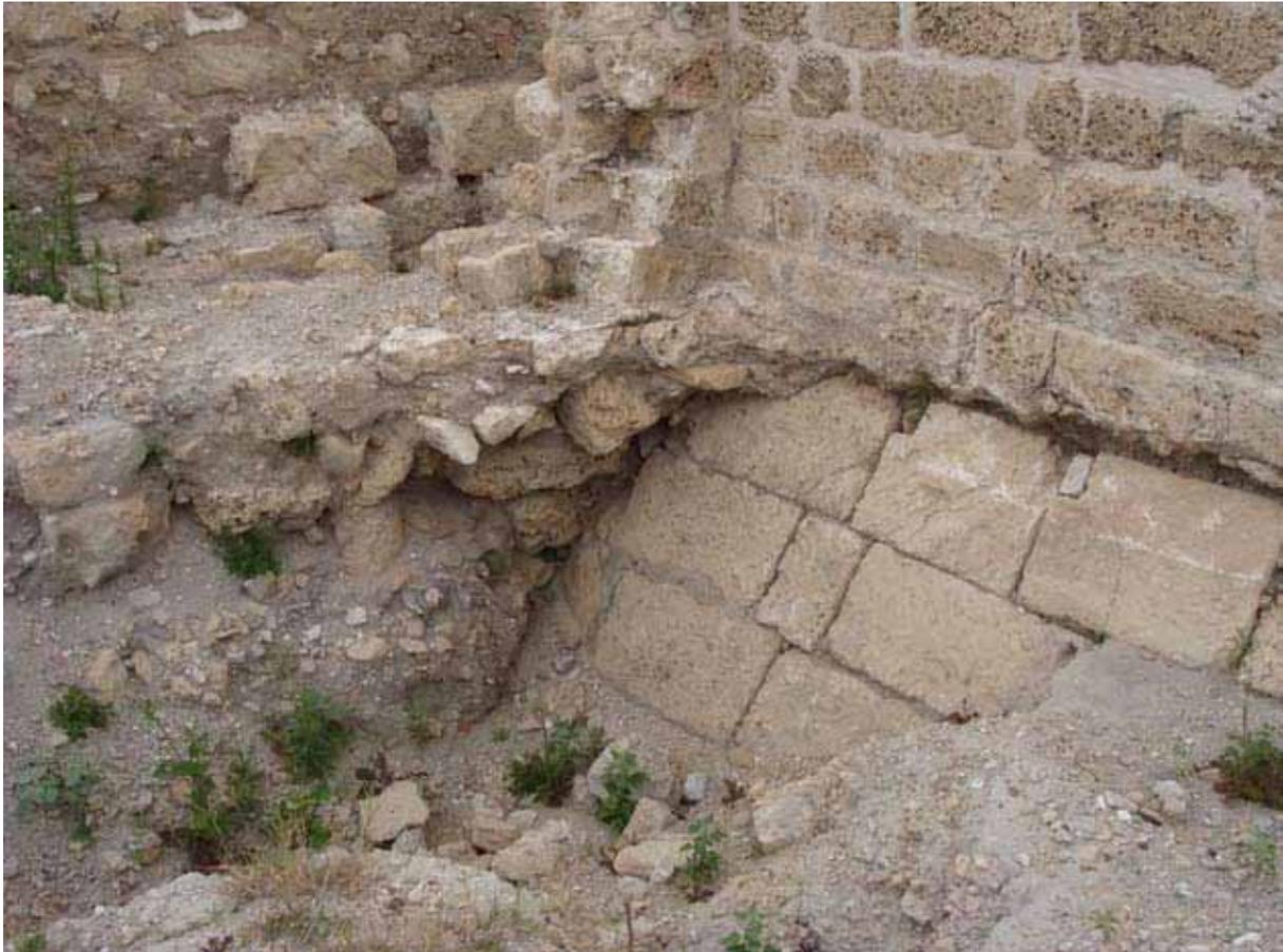
**Figure 49 : Raccord de la courtine M22 et du mur M20 sur son glacis en mai 2010. Au fond, l'épaississement extérieur (M23), sur lequel sont collées quelques pierres du parement de l'ancienne courtine M22 primitive. Au premier plan, l'épaississement du mur M20, en surplomb sur l'ancien glacis qui file sous l'angle M20/M22, et, en coupe, la fondation de la courtine M22, qui cachait l'ancien glacis.**
