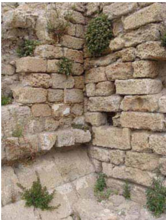
**Figure 50 : Raccord entre le mur M24 (à droite) et le mur M10 (à gauche). On note la présence du glacis primitif (UM 3055), et au-dessus le mur construit sous Saint Louis, les deux étant collés contre M24 qui leur est antérieur.**
