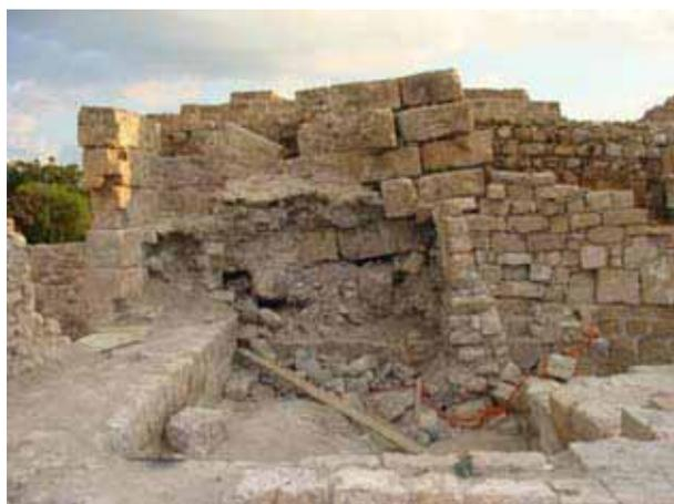
**Figure 43 : Vue du mur M3 depuis le Sud en 2008, avant les consolidations de 2009 de la partie intermédiaire (UM 3001).**
