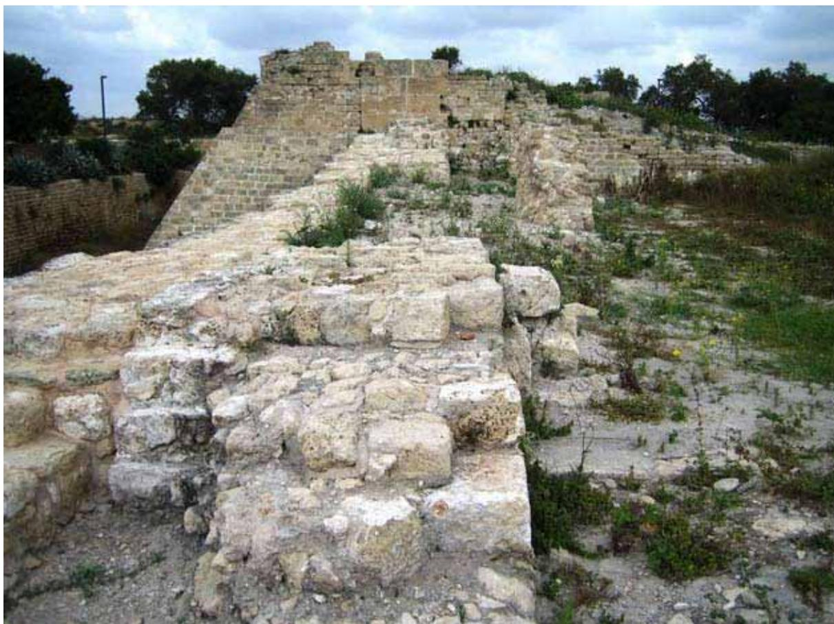
**Figure 32 : Vue de la courtine 2-3 prise depuis l'Ouest. Au fond, la tour T3. Au premier plan, de gauche à droite, l'arase du glacis tronqué, l'élargissement Louis IX, et le long de ce dernier, quatre assises du parement de la courtine primitive disparue**
