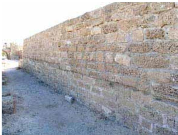
**Figure 158 : Vue du massif d'accès à la tour collé à la courtine primitive à son revers, à l'Ouest, prise depuis le Sud-Ouest. Noter le bandeau marquant la limite de la restauration**
