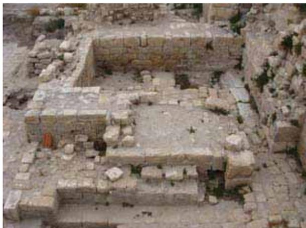
**Figure 44 : Vue de la tour Ouest prise depuis l'Est en 2010. A droite, fondation sur entablements antiques.**
